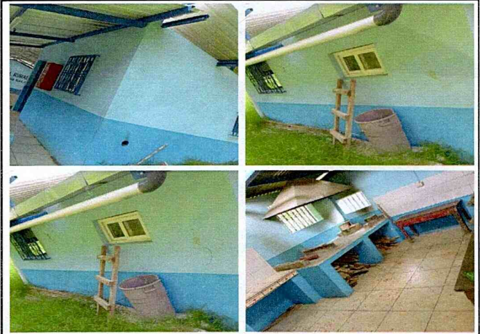
Foto 2: Mejoramiento en su estructura total en la ampliacion de la cocina y de un polleton con chimenea o salida de humo para el uso del nivel preprimario.
