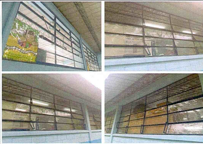
Foto 1: Mejoramiento en su estructura total de las ventanas y venatales del area de nivel preprimario.
